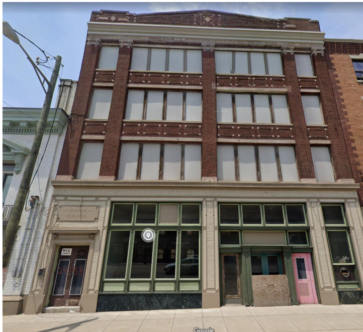
2453 Gilbert Ave - Rehab
